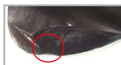
Danneggiamento dovuto ad un carico eccessivo
